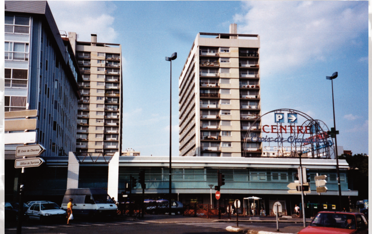
La façade sud en 2002 (après réhabilitation)
